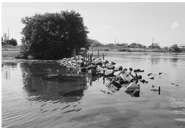
14 高島市 深溝浜地区湯水状況 石積み突堤が露頭している。 1994年8月18日撮影
