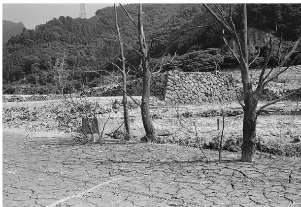
19 東近江市 永源寺ダムの渇水状況② 1994年8月撮影
