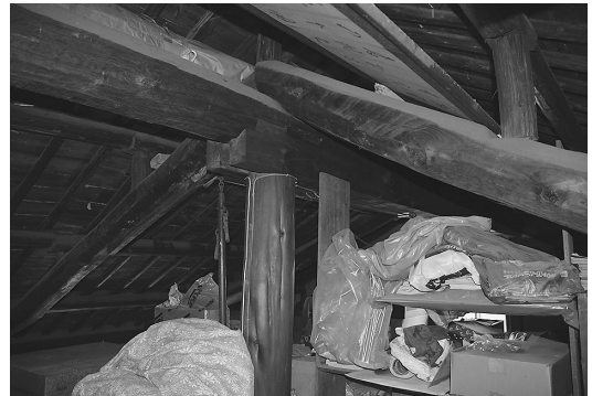
写真6 O家住宅三階蔵の小屋組み 小林家住宅三階蔵同様、独立柱の頂部に、2本の地棟を架けている
