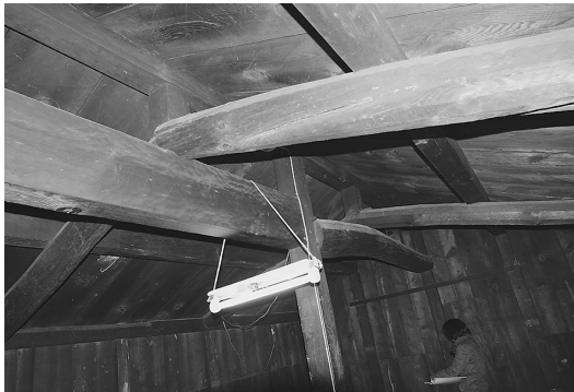
写真5 小林家住宅三階蔵の小屋組み 独立柱の頂部に、2本の地棟を架けている
