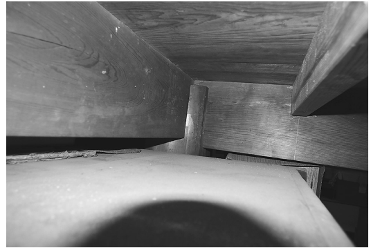
写真7 N家住宅三階蔵の2階天井(3階床組) 独立柱に中引き梁と大引きが直交するように架けられ、その上に根太と床板が載っている。
