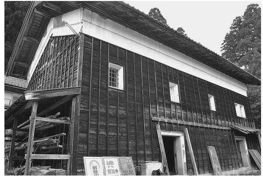
写真2 山岸家住宅米蔵・板蔵
