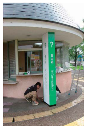
学内サインの設置
