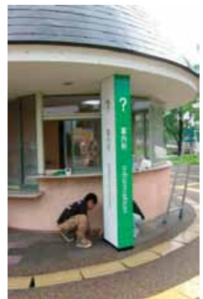
学内サインの設置
