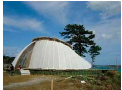
被災地に建設した竹の建築
