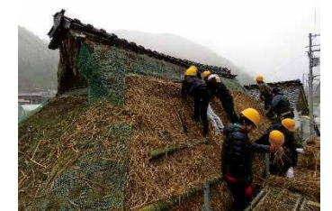
茅葺き屋根の修復
