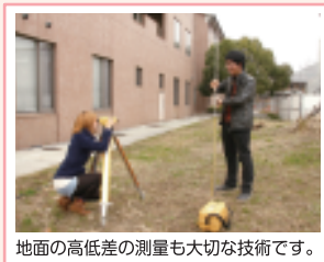
地面の高低差の測量も大切な技術です。
