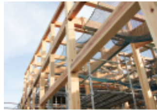
▲工事中の様子
