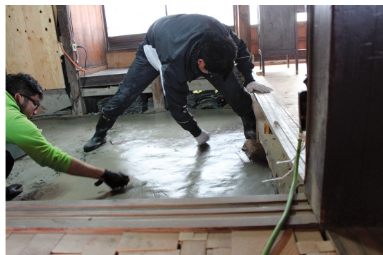
満ち家の一間を解体して土間へと改修しているところです。
