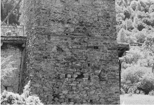
写真17 充填した出入口
