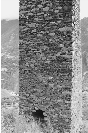
写真18 充填した出入口
