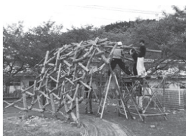
写真25 ドーム頂部連結
