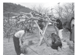
写真30 掘立基礎部作成
