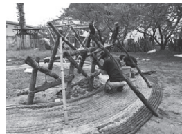
写真24 ユニット連結
