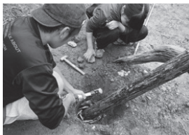
写真23 掘立基礎作成
