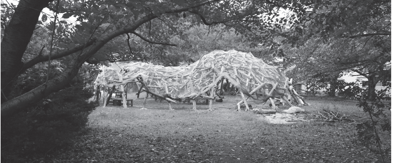
図1 2019年11月に完成した実験体
