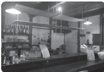
キッチンに吊り棚を設置 (11/08)
