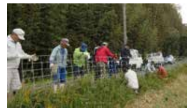
集落住民による 共同の被害防除柵の設置
