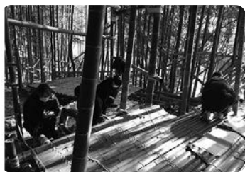
テージ床仕上げ材取り付け (12/11)
