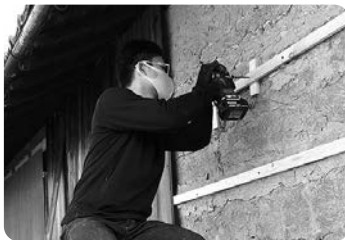
外壁の改修作業（12/11）
