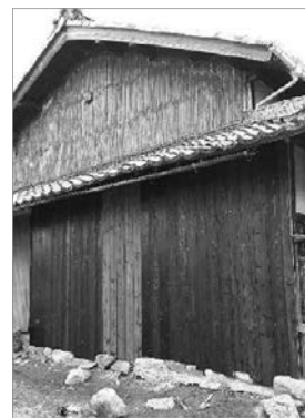
古民家改修 外壁の焼き板の張り替え
